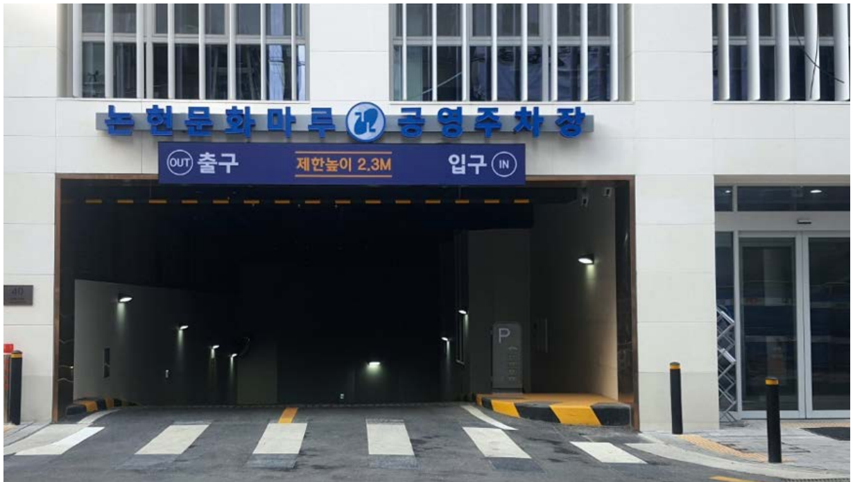
▲ 논현문화마루 공영주차장 전경
